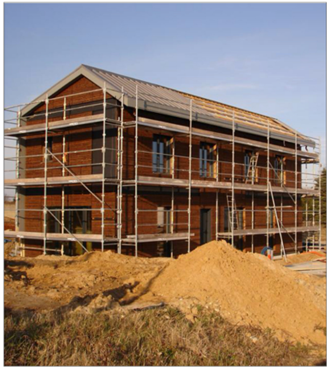
■ Une maison passive en construction. Photo Christophe GALLET
